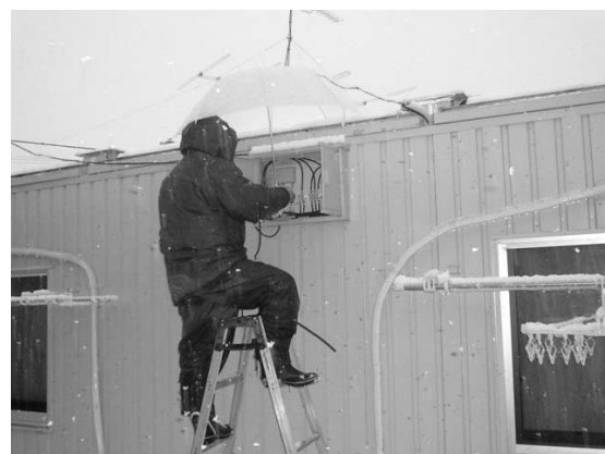
雪の中で増幅器の設置工事
