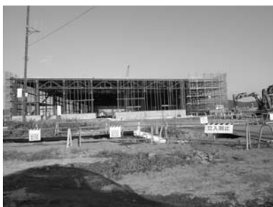
石巻市新蛇田地区の災害公営住宅 建設工事
