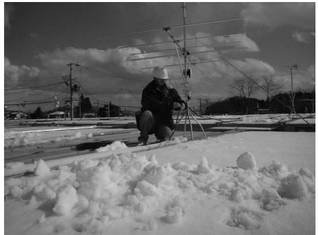
屋根の上での受信アンテナ設置作業
