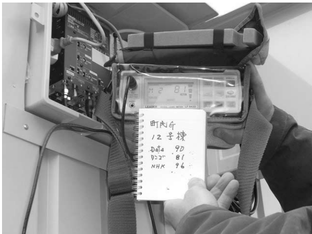
工事箇所ごとに電波強度を確認
