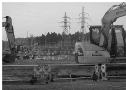
石巻市新蛇田地区の災害公営住宅 建設工事
