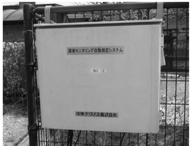
飯館村役場の前に設置された環境モニタリング自動測定システム
