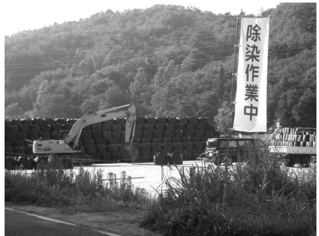
飯館村の除染作業の様子
