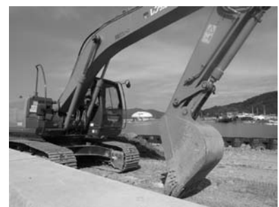
石巻市新しい魚市場建設現場
