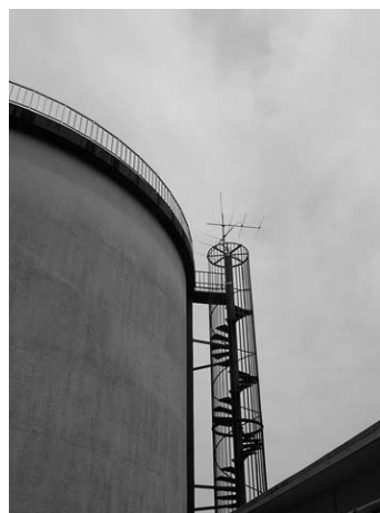
山上の水道タンクに併設した送信アンテナ (亶理町)
