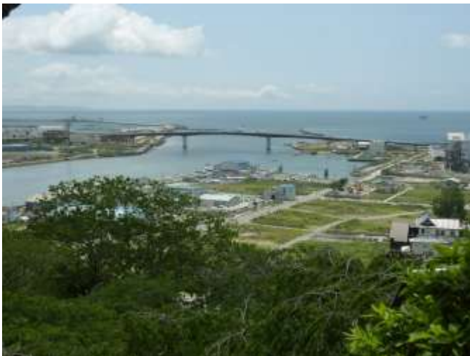
被災したの宮城県石巻市沿岸部 ～日和山公園より～
