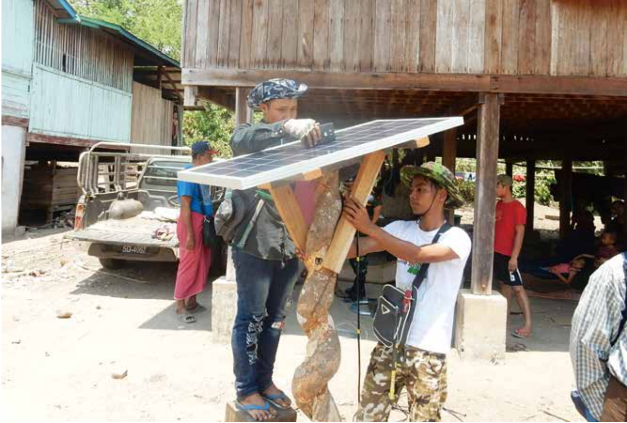
Kyaw Kho 村ソーラーパネル設置工事状況（第3期）
