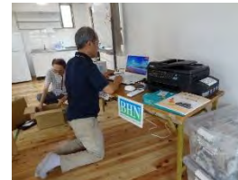
ICT設備設置工事 (集会所)
