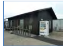
仮設住宅団地 集会所
