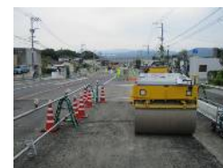
県道28号(熊本高森線)益城町市街部3.5Kmを都市計画道路益城中央線として 拡幅工事
