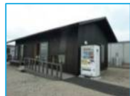
仮設住宅団地 集会所
