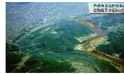
バックウォーター現象の発生を抑える高梁川・小田川合流地点付替工事
