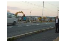
石巻市内陸部 蛇田地区を造成 大規模復興団地 石巻市 のぞみ野地区
