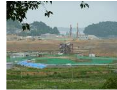
大規模な 嵩上げ工事 震災遺構 ・旧防災庁舎 (南三陸町)
