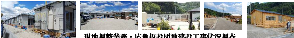
現地調整業務・応急仮設団地建設工事状況調査 (2018年8月23日～29日撮影)
