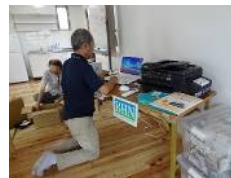
ICT設備設置工事 (集会所)
