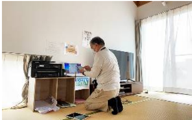
仮設住宅団地集会所に開設し たBHNパソコンコーナーの 定期巡回設備点検 (令和2年7月豪雨)
