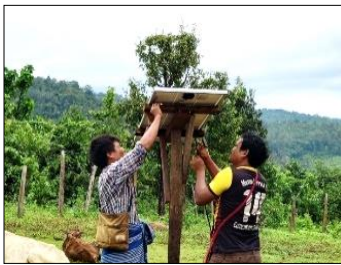
ミャンマー カレン州・モン州での紛争被害地域の電化事業 「2022年1月 家庭用ソーラーパネルの設置工事」
