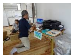
ICT設備設置工事 (集会所)
