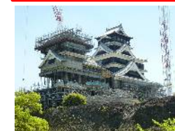
熊本県のシンボル見せる熊本城復興工事
