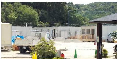
呉市・安浦 応急仮設団地
