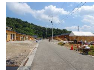
三原市・あやめヶ丘 応急仮設団地
