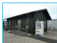
仮設住宅団地 集会所
