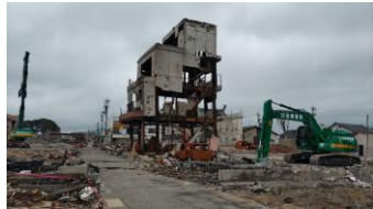
石川県輪島市河井町 朝市通り 被災ビル・ 被災家屋の解体工事 (2024年7月6日撮影)
